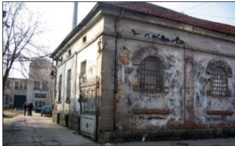
Najteže tekstilcima: Oronula fabrička zgrada firme Kosta Stamenković
